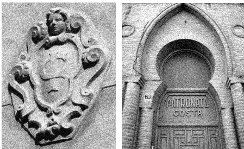
Fundación Tomás Costa en Los Navalmorales. Acceso principal (1931) y escudo con las iniciales de Tomás Costa, del gusto de la época, en la fachada posterior.
