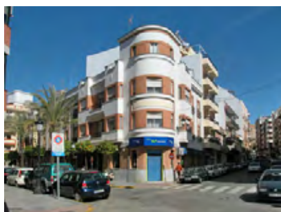
📍 VIVIENDAS Y COMERCIO. HUELVA. 1940 (A) Calle San José, n.º 18 Sedano Arce, Francisco
