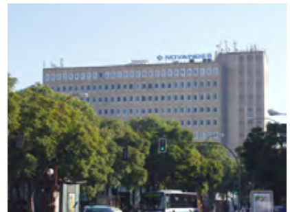
📍 EDIFICIO DE OFICINAS SEVILLA 1. SEVILLA. 1972 (A) Avenida San Francisco Javier, n.º 24, avenida Ramón y Cajal Gómez-Estern Sánchez, Luis Fernando Medina Benjumea, Felipe Trillo de Leyva, Manuel Villanueva Sandino, Fernando
