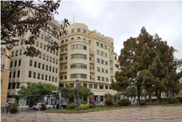
Edificio Transmediterránea en Cádiz (Antonio Sánchez Esteve, 1938)
