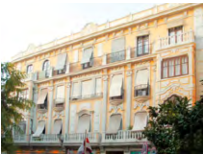
📍 EDIFICIO EN PLAZA FLORES. ALMERÍA. 1924 (A) Plaza Flores, n.º 1 Langle Rubio, Guillermo
