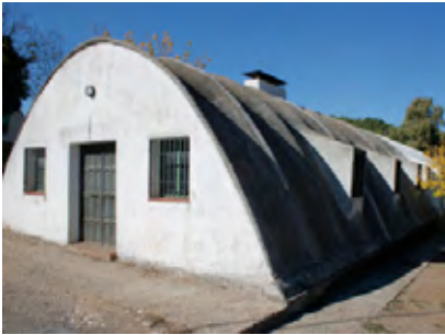
📍 VIVIENDAS ULTRABARATAS. VILLAVICIOSA DE CÓRDOBA. 1953 (A) Carretera n.º 3075 El Vacar-Puente Nuevo-Villaviciosa García de Paredes Barreda, José María La-Hoz Arderius, Rafael de
