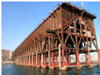
📍 CARGADERO DE MINERAL EL ALQUIFE. ALMERÍA. 1902/1904 (A) Playa de las Almadrabillas
