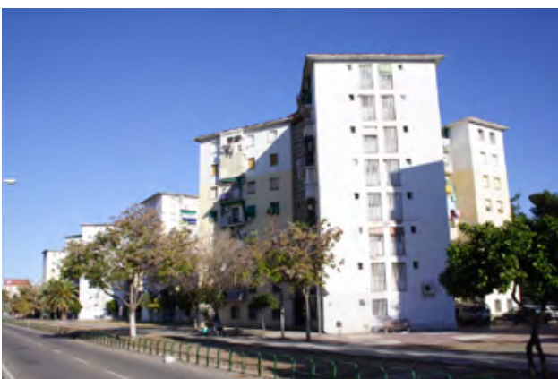
Viviendas del Caracol. Vista del conjunto desde la avenida de Cádiz Fotos: Fondo Gráfico IAPH (Francisco Daroca Bruño)
