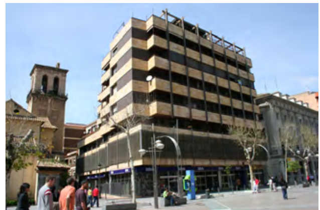
Edificio del Banco de Bilbao en Córdoba (Francisco Hurtado de Saracho y Epalza, 1976). Foto: Fondo Gráfico IAPH (Francisco Daroca Bruño)
