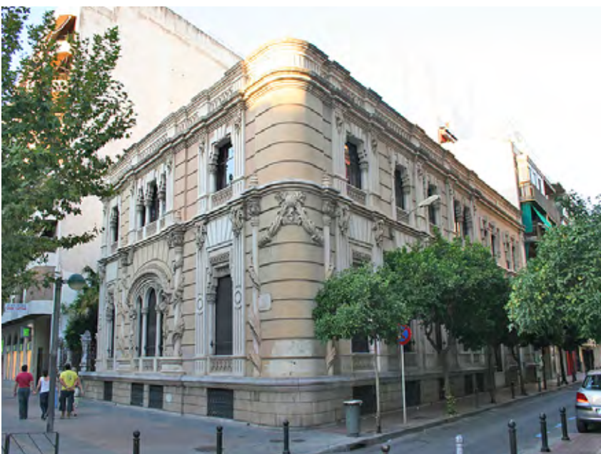
Casa Álvarez Cid (actual Colegio de Arquitectos) en Córdoba (Adolfo Castiñeyra Boloix, 1907). Fotos: Fondo Gráfico IAPH (Francisco Daroca Bruño)
