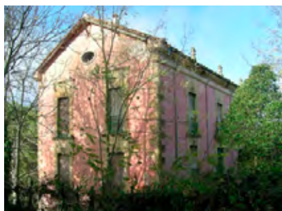
📍 VILLAS ARÉVALO, MARÍA LUISA Y SAN JOSÉ EN LA YEDRA. BAEZA, JAÉN. 1900 (A) Carretera nacional n.º 322
