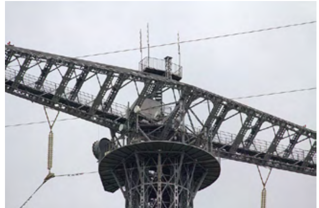
Torre de tendido eléctrico de Puntales (Nero Scalla y Alberto Toscano, 1955)
