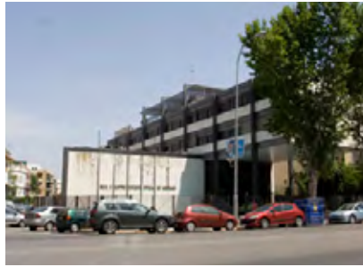
📍 SEDE DEL REAL E ILUSTRE COLEGIO MÉDICO. SEVILLA. 1972 (A) Avenida de la Borbolla, n.º 47, calle Porvenir, calle Progreso La-Hoz Arderius, Rafael de Olivares James, Gerardo Foto: J. Manzano. Fuente: Docomomo
