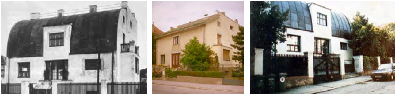
Casa Steiner en Viena (Adolf Loos, 1910). Estado original (izquierda), reformado (centro) y actual tras la última restauración (derecha). Fuente: MARCOSANO DELL'ERBA, 1998
