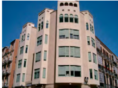
📍 VIVIENDAS EN CALLE CÍSTER. MÁLAGA. 1927 (A) Calle Císter, n.º 19 Palacios Ramilo, Antonio
