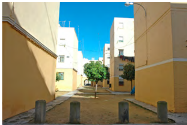
Barriada de la Barzola, Sevilla (José Fonseca y Llamedo, 1942). Vía peatonal
