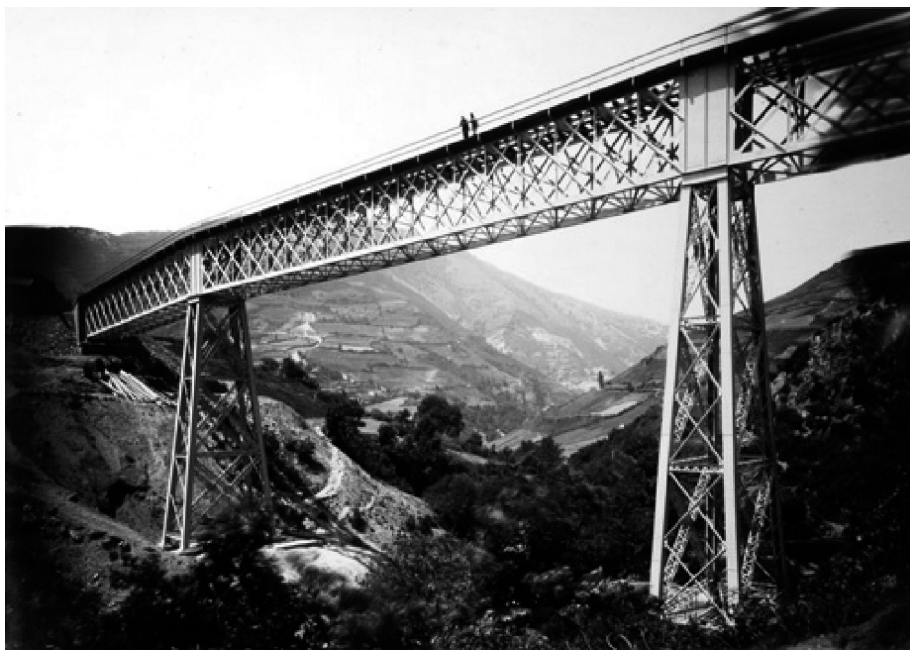
P. Sauvanaud. Puente metálico del fc. de Asturias, Galicia y León, ca. 1884. Biblioteca Nacional.
