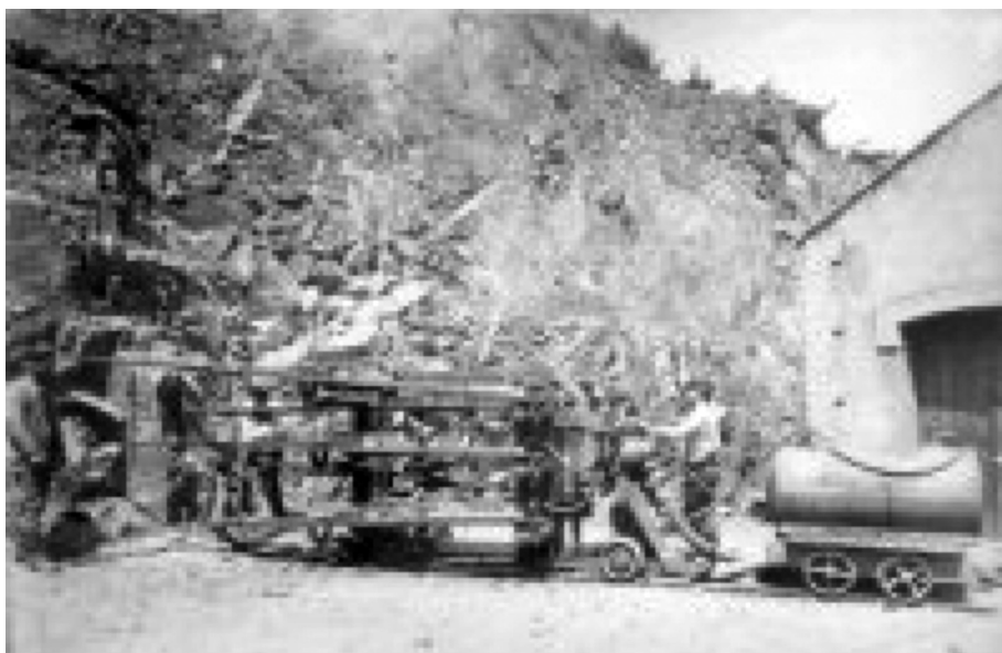
P. Audouard. Carro con perforadora en el túnel de La Argentera. Archivo Histórico Ferroviario.
